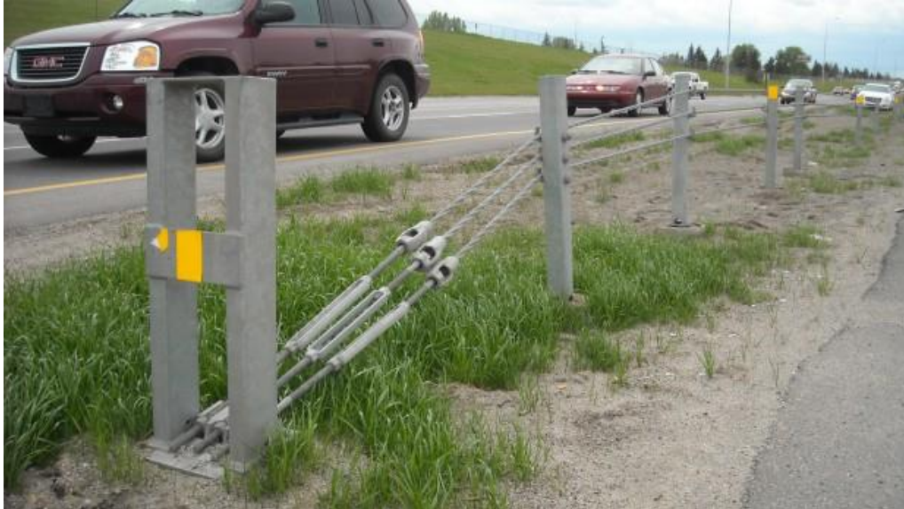
Figur 16: Markförankring av vajerräcken. 68
