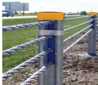
Figur 15: Reflektorer på vajerräcken. 63
