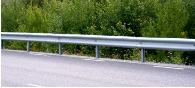
Figur 7: W-profil räcken. 40
