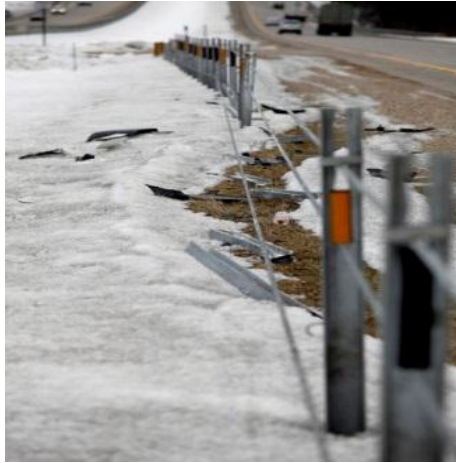
Figur 14: Skador på ett vajerräcke efter en mindre krock. 62
